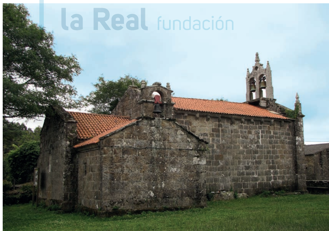
Exterior desde el lado norte
