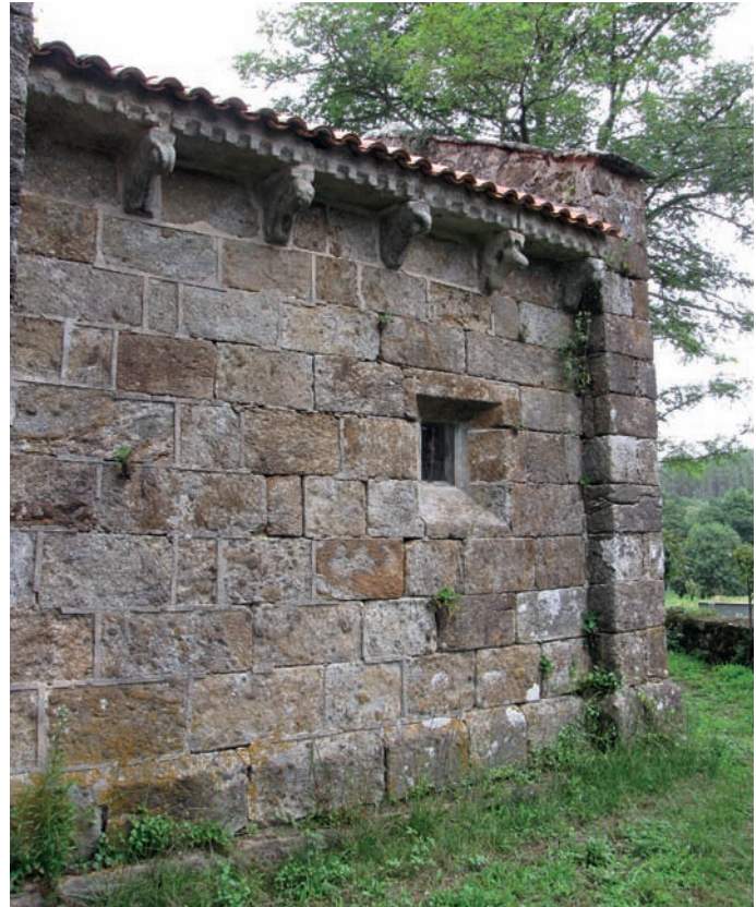
Muro sur de la cabecera
