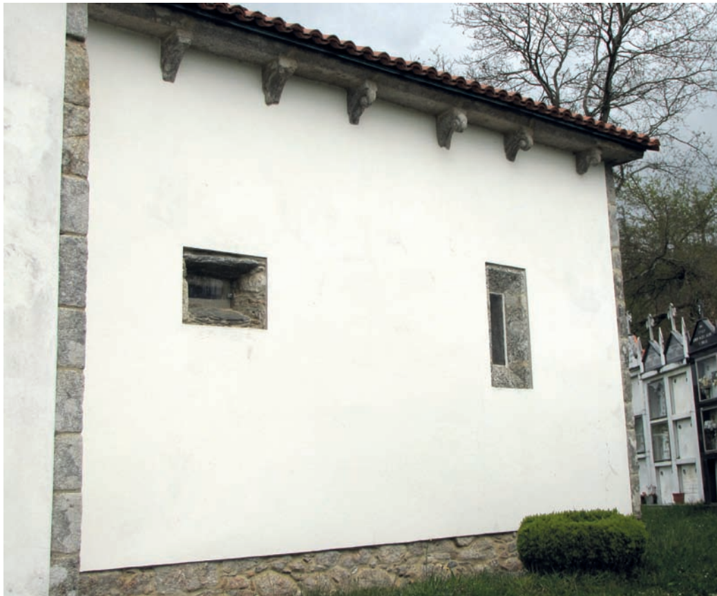
Muro sur de la cabecera
