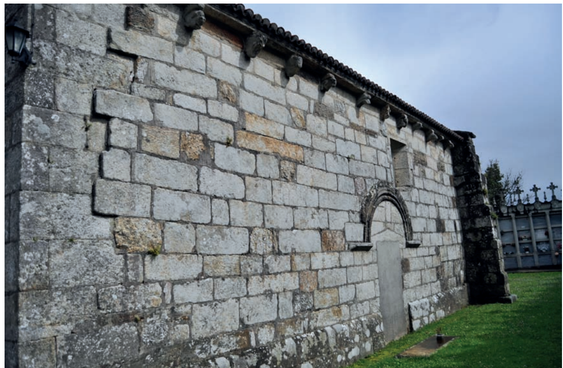
Muro sur de la nave
