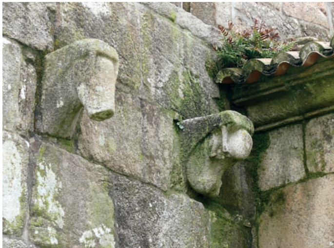
Canecillos del muro norte de la cabecera
