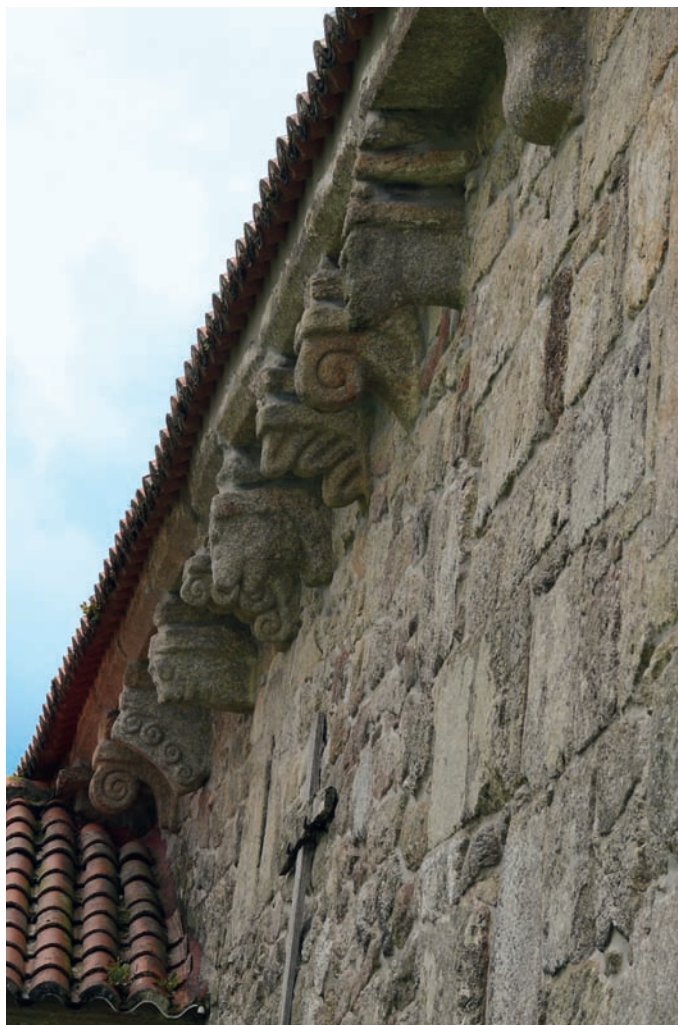
Canecillos del muro norte de la nave
