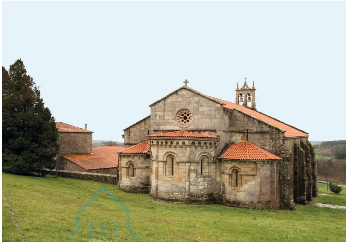
Panorámica del conjunto
