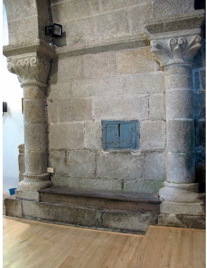
Columnas del lado norte del ábside
