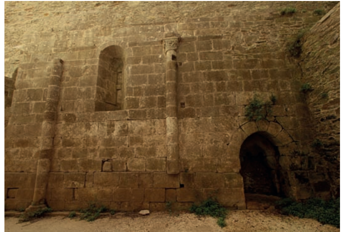
Detalle del muro románico
