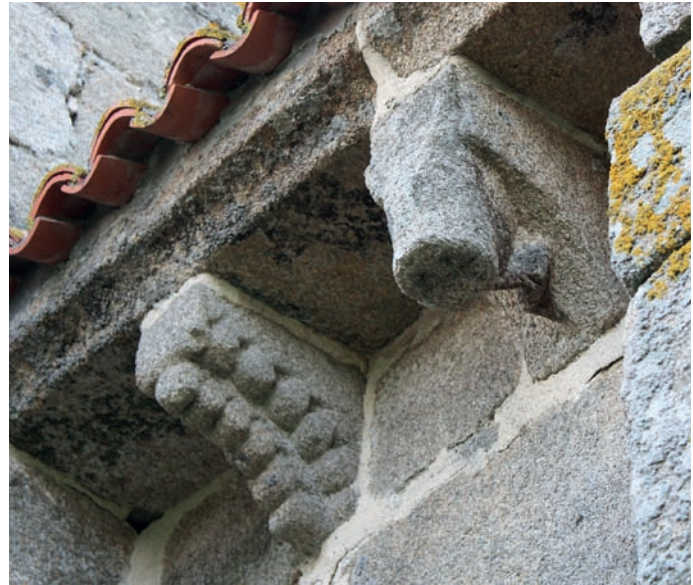
Canecillos de la cabecera. Muro sur
