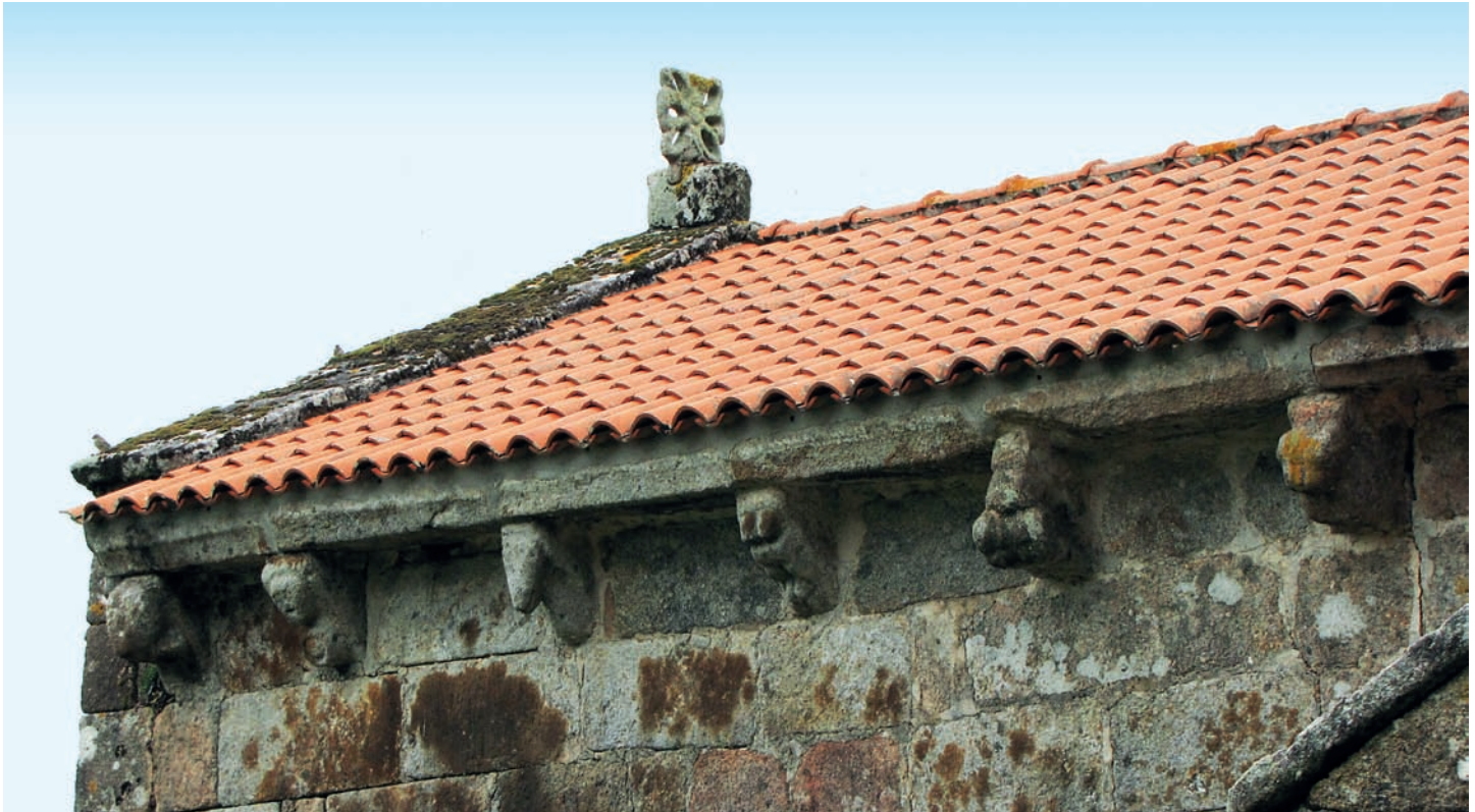
Canecillos del muro sur
