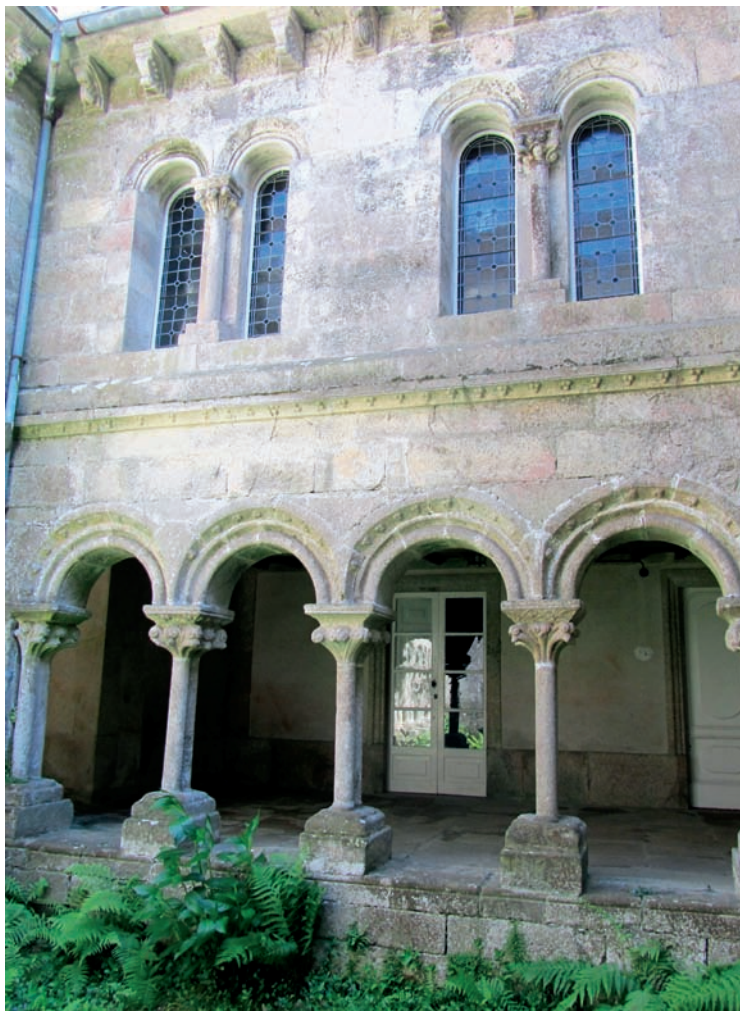
Galería del claustro
