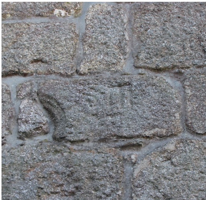
Canecillo o ménsula empotrada en el muro norte
