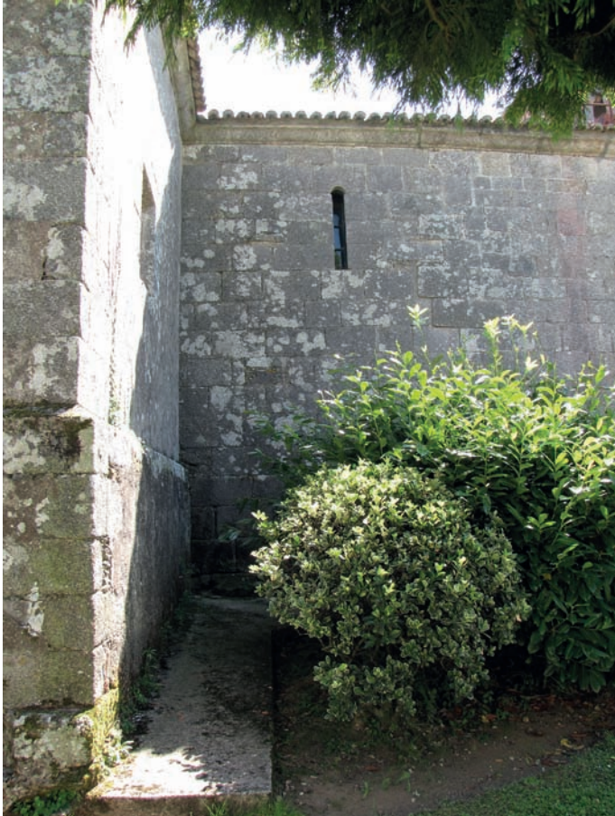
Muro norte con saetera románica
