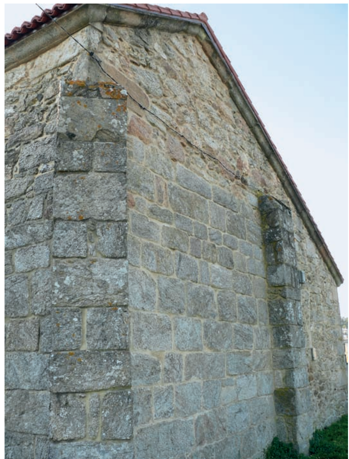
Muro este de la cabecera
