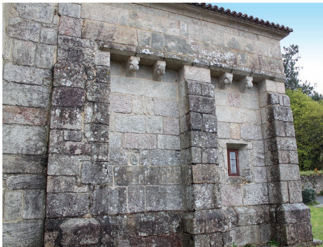
Muro sur de la cabecera
