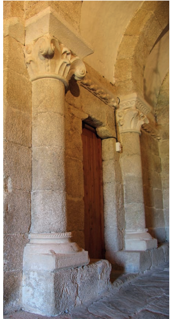
Detalle de las columnas de la cabecera
