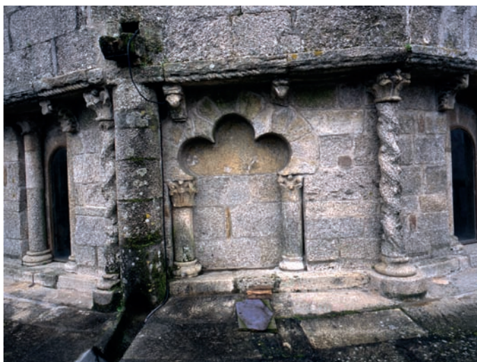
Parte alta del muro exterior del presbiterio
