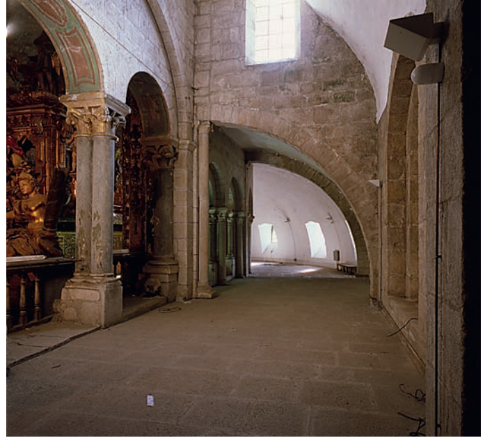
Tribuna. Tramo meridional previo a la girola
