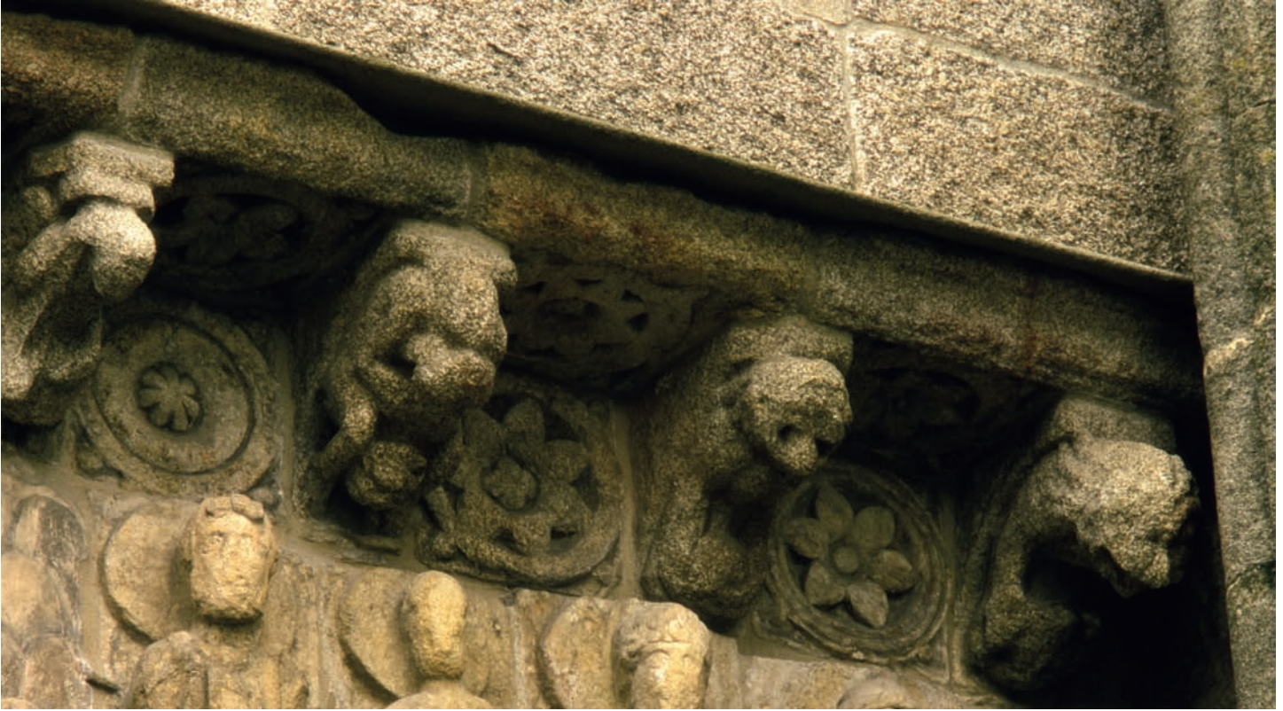
Detalle del alero de la fachada de Platerías
