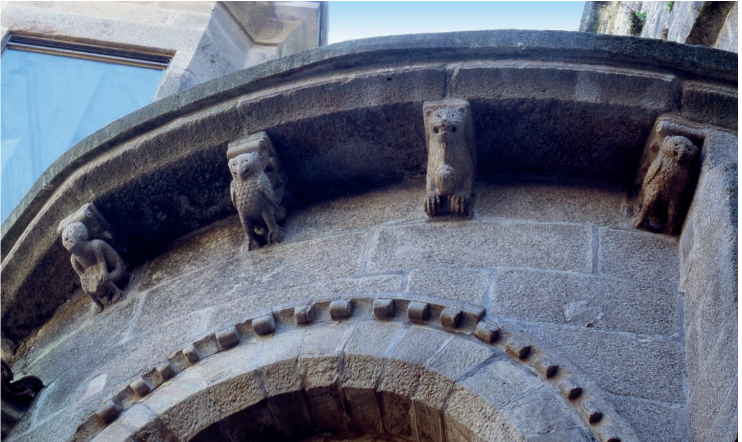
Detalle del alero de la capilla de San Juan
