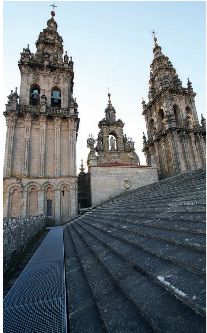
Cubierta de granito de la Catedral
