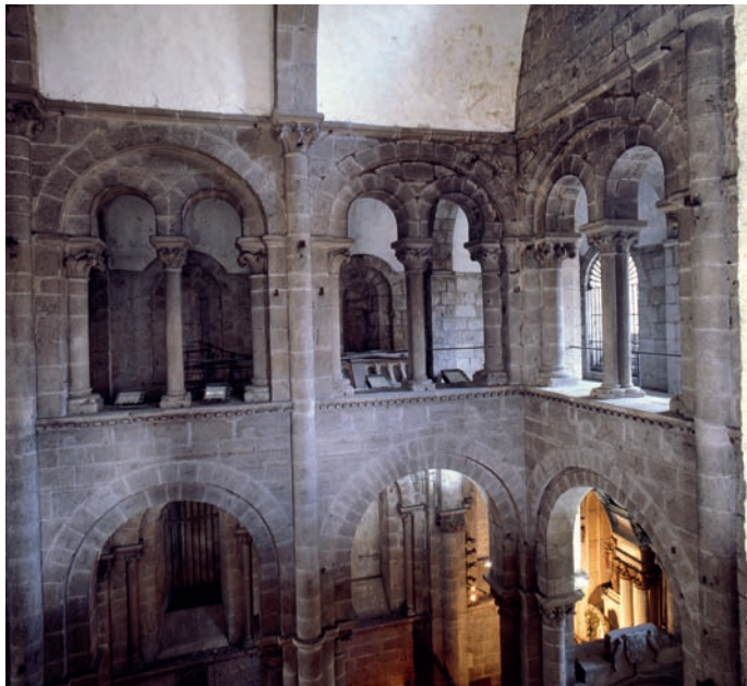
Detalle del muro oriental de la nave central del crucero meridional
