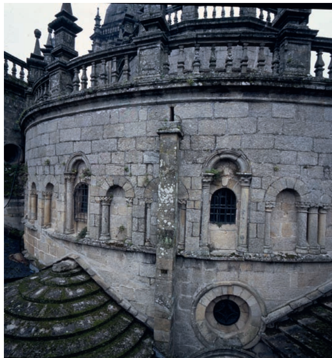
Muro exterior de la girola de la tribuna
