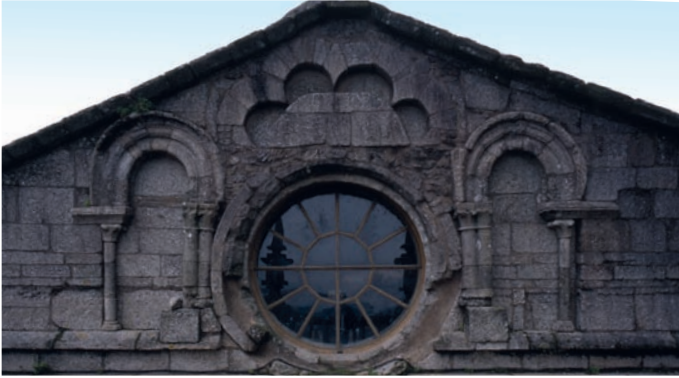
Remate de la parte alta de la nave del crucero
