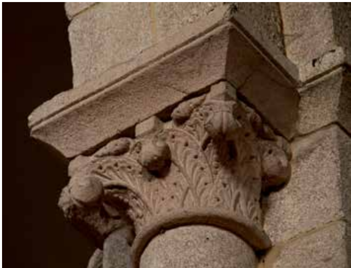
Capitel de las naves
