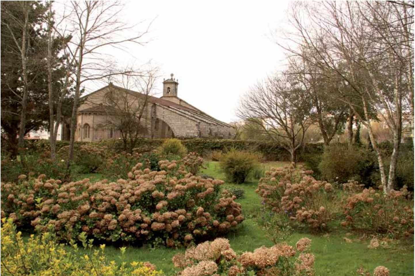
Vista desde el lado este
