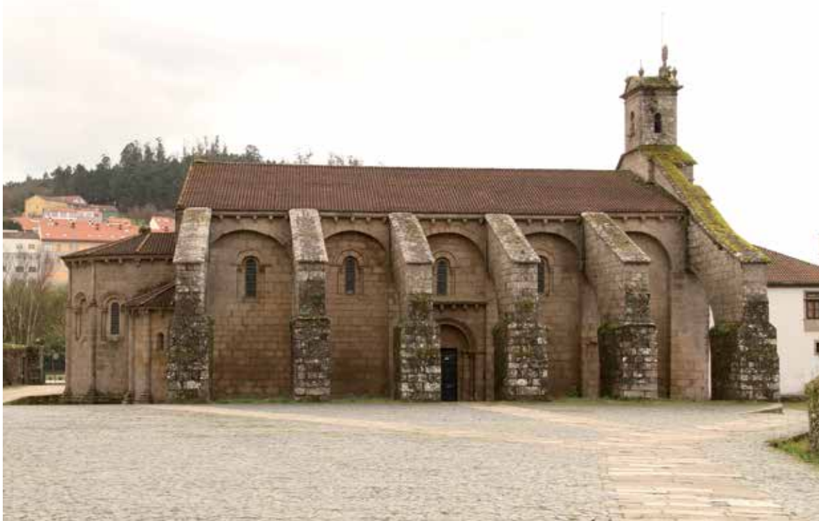
Vista desde el lado norte
