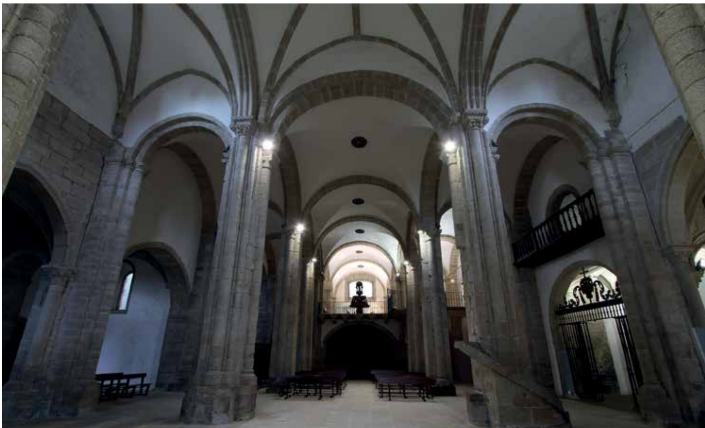
Vista de la nave
