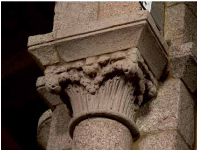
Capitel de las naves
