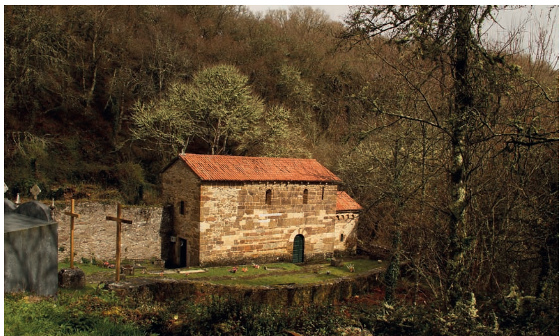
Vista del emplazamiento
