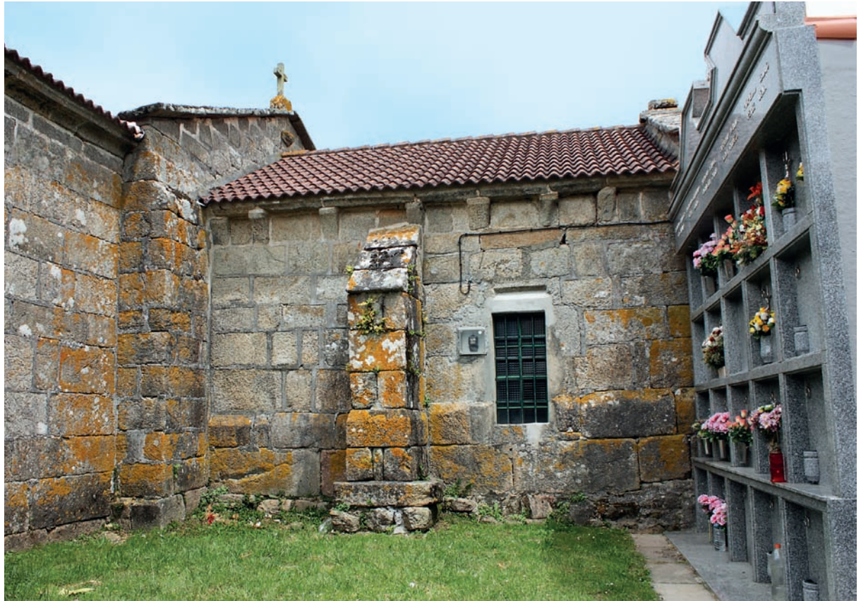
Muro sur de la cabecera
