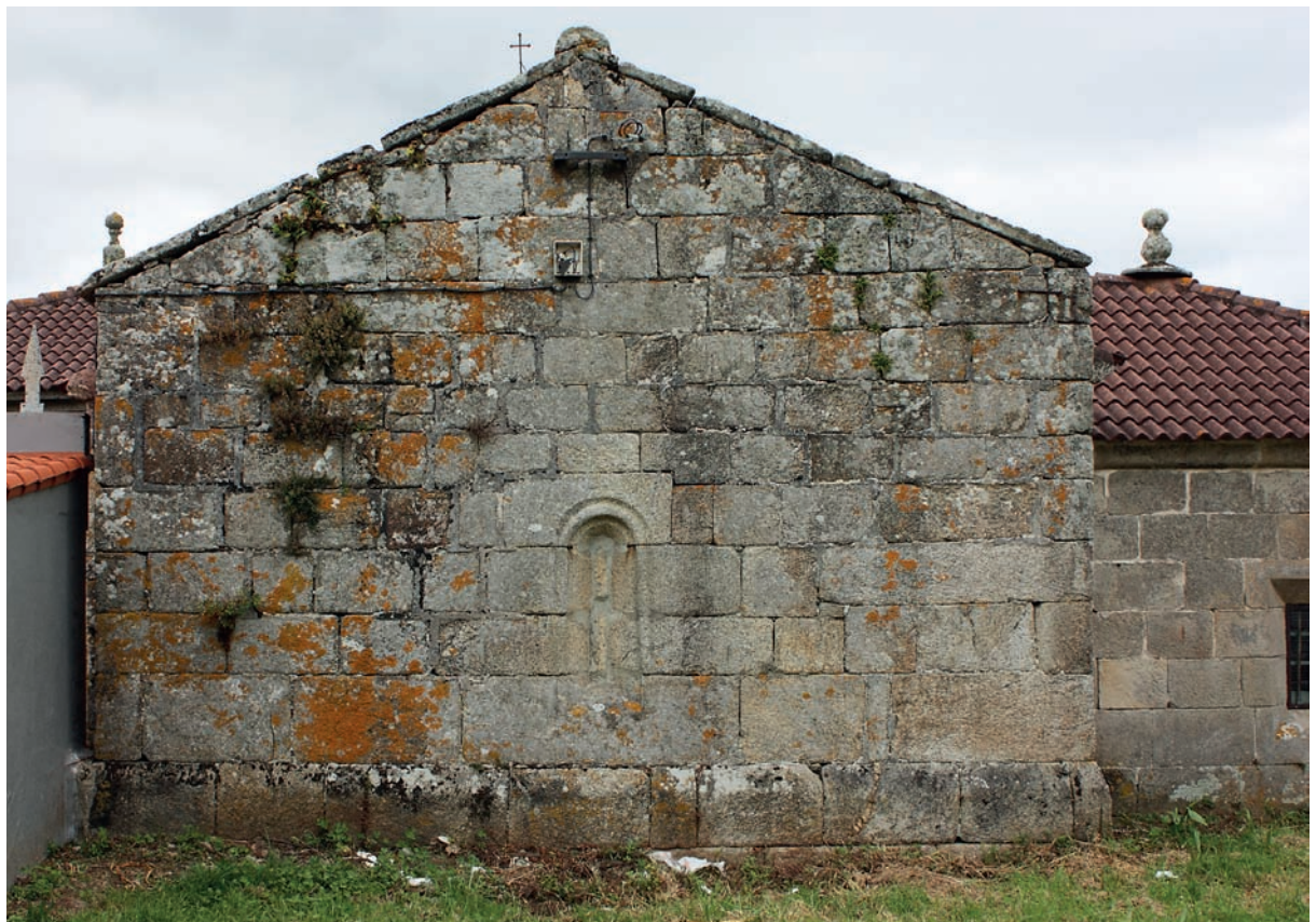
Muro este de la cabecera
