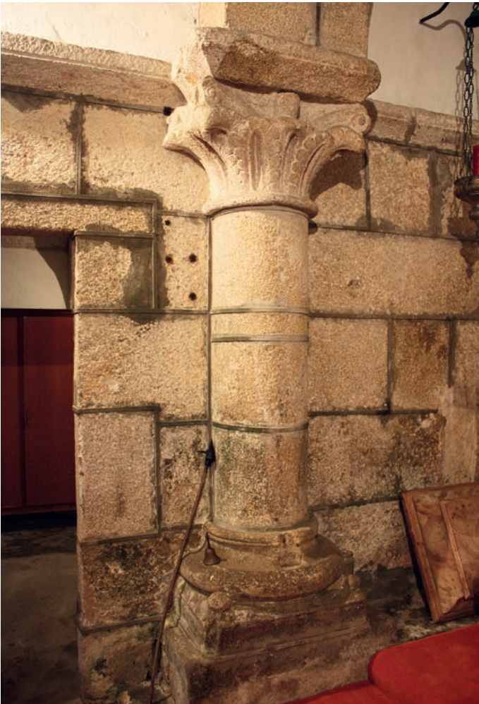
Columna del arco fajón
