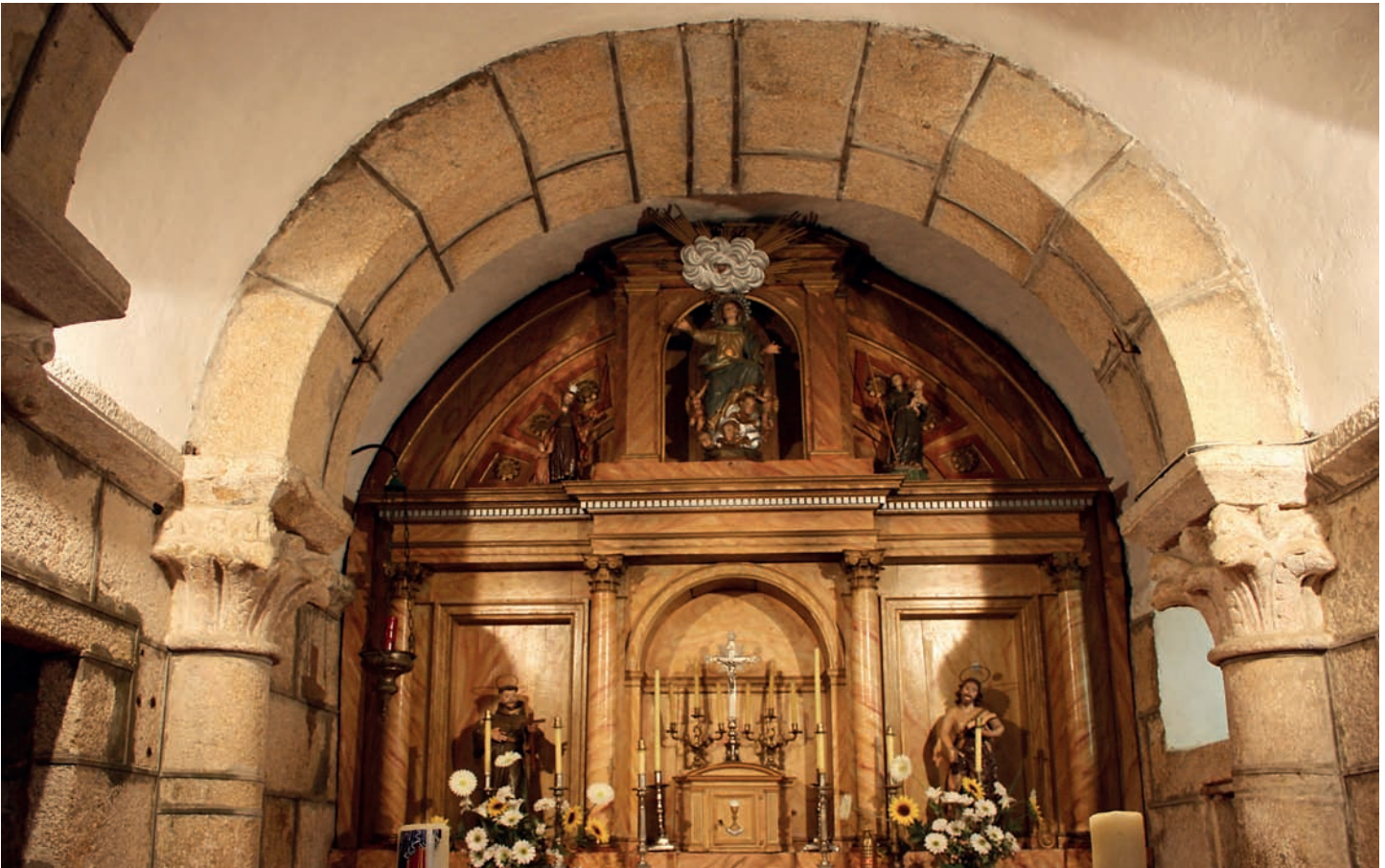
Arco fajón de la cabecera
