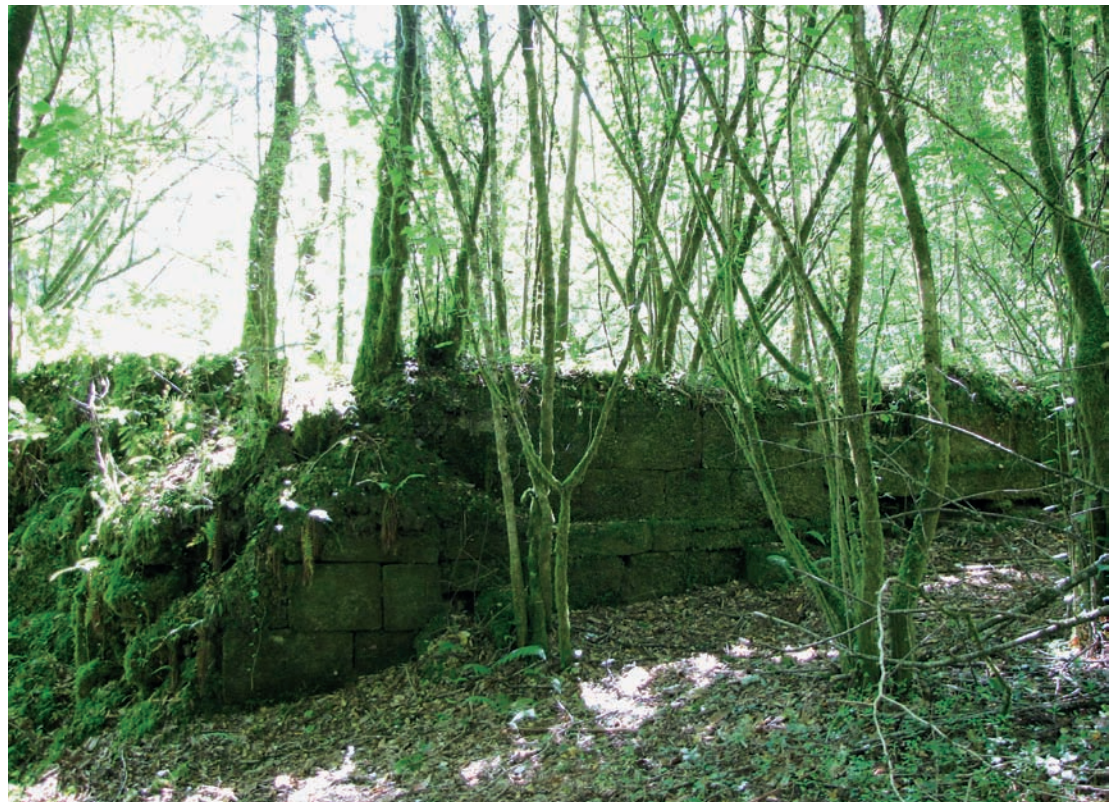
Restos del muro norte
