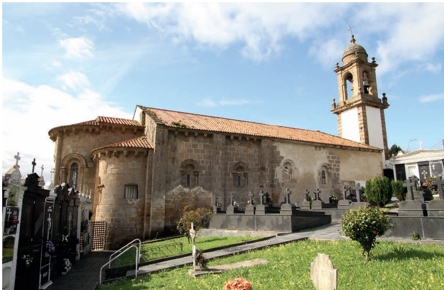
Vista desde el lado norte
