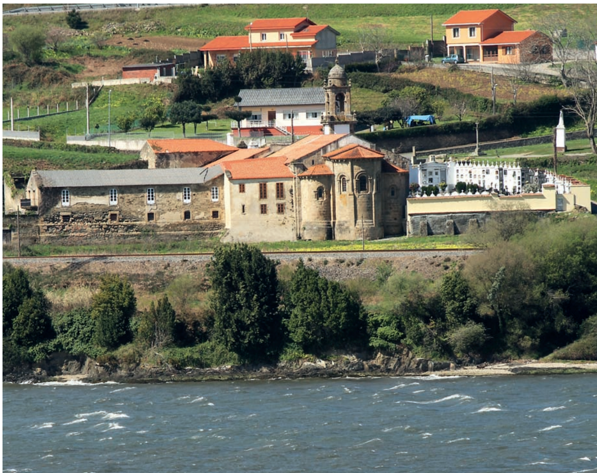
Panorámica del emplazamiento
