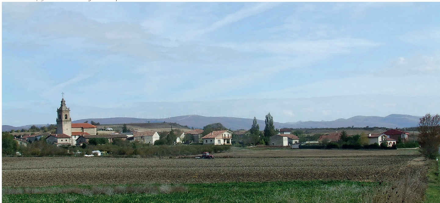
Herriaren ikuspegi orokorra / Vista general del pueblo
