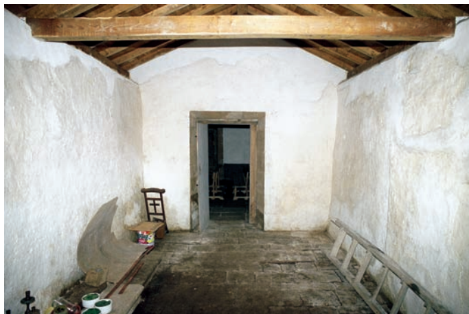
Interior. Vista occidental
