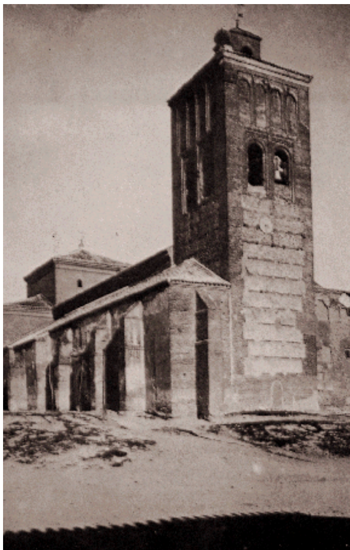
La torre antes del derrumbe. Foto de Gómez-Moreno
