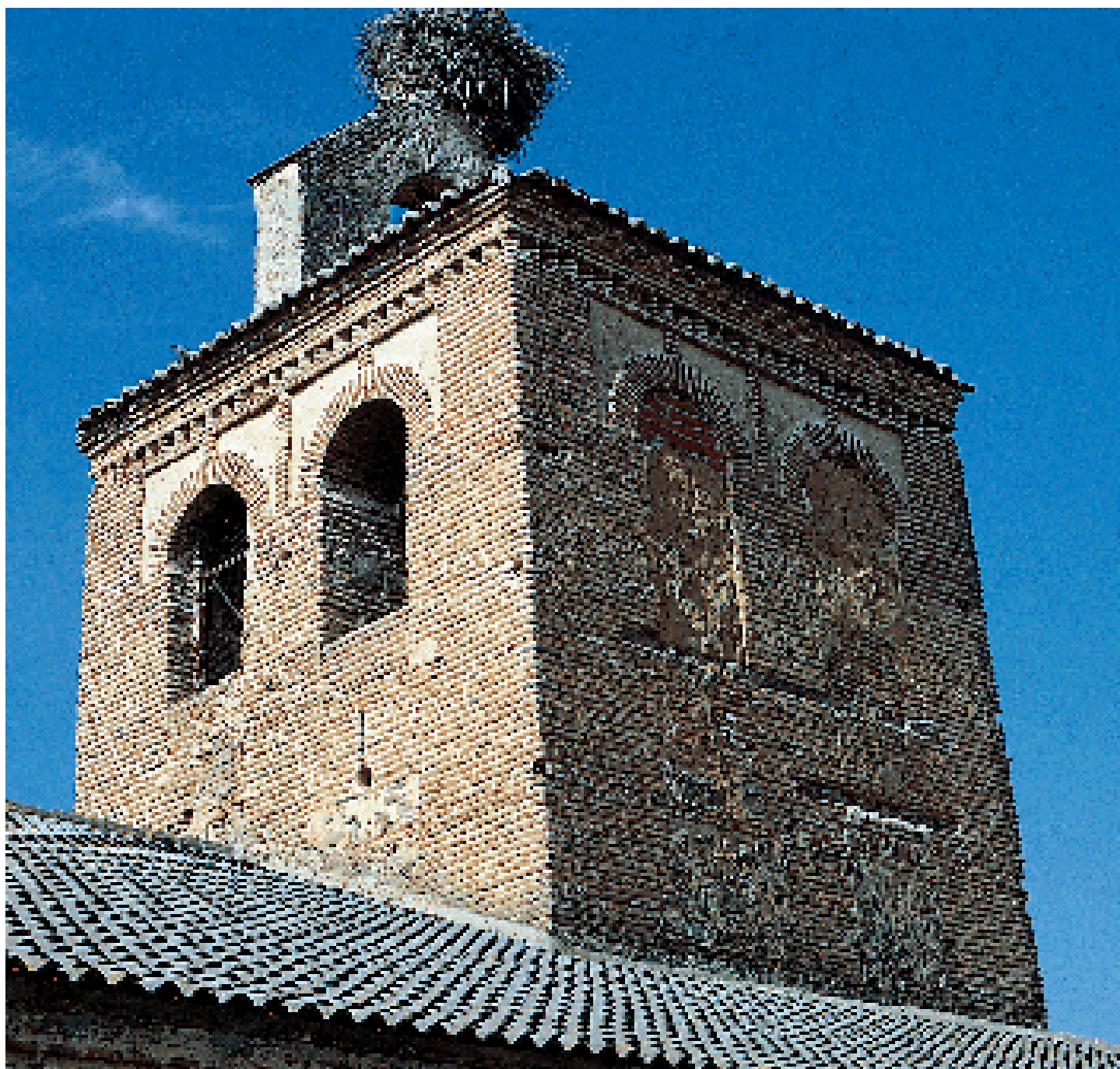
Detalle de la torre
