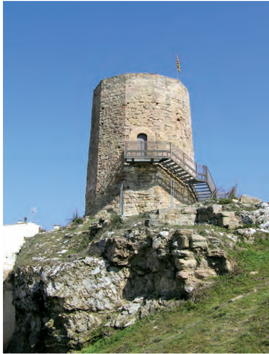
Torre poligonal Detalle de la torre
