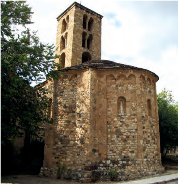
Vista general de la cabecera
