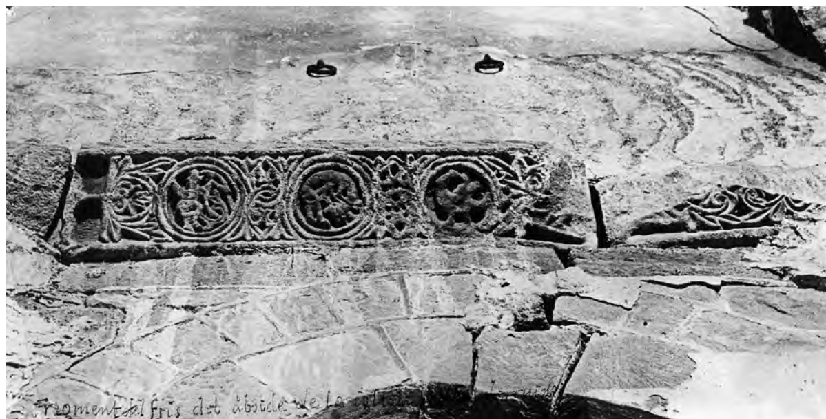
Friso del interior del ábside. 1967. ©Servei de Patrimoni Arquitectòmic Local Diputació de Barcelona
