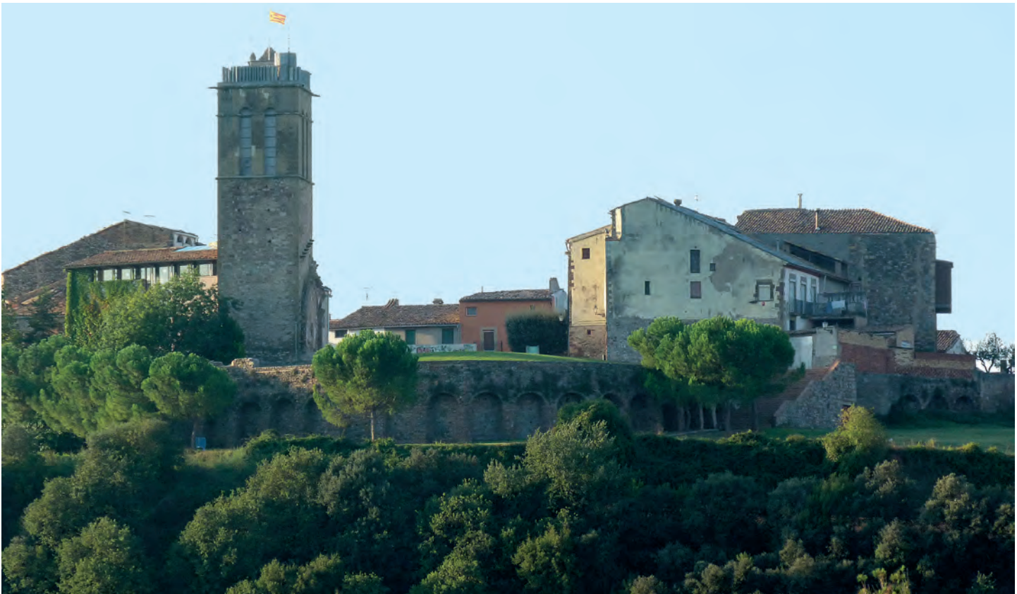
Vista general desde el Norte
