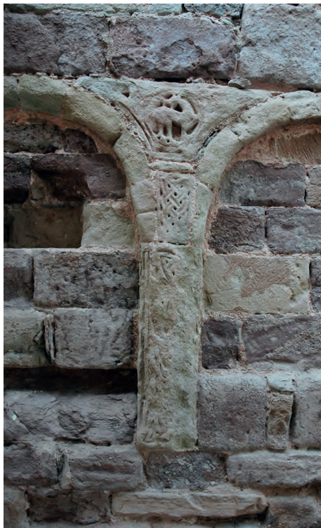
Relieves centrales de la decoración arquitectónica del exterior del ábside
