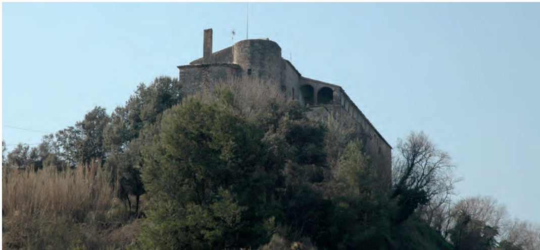
Vista del conjunto desde el Este
