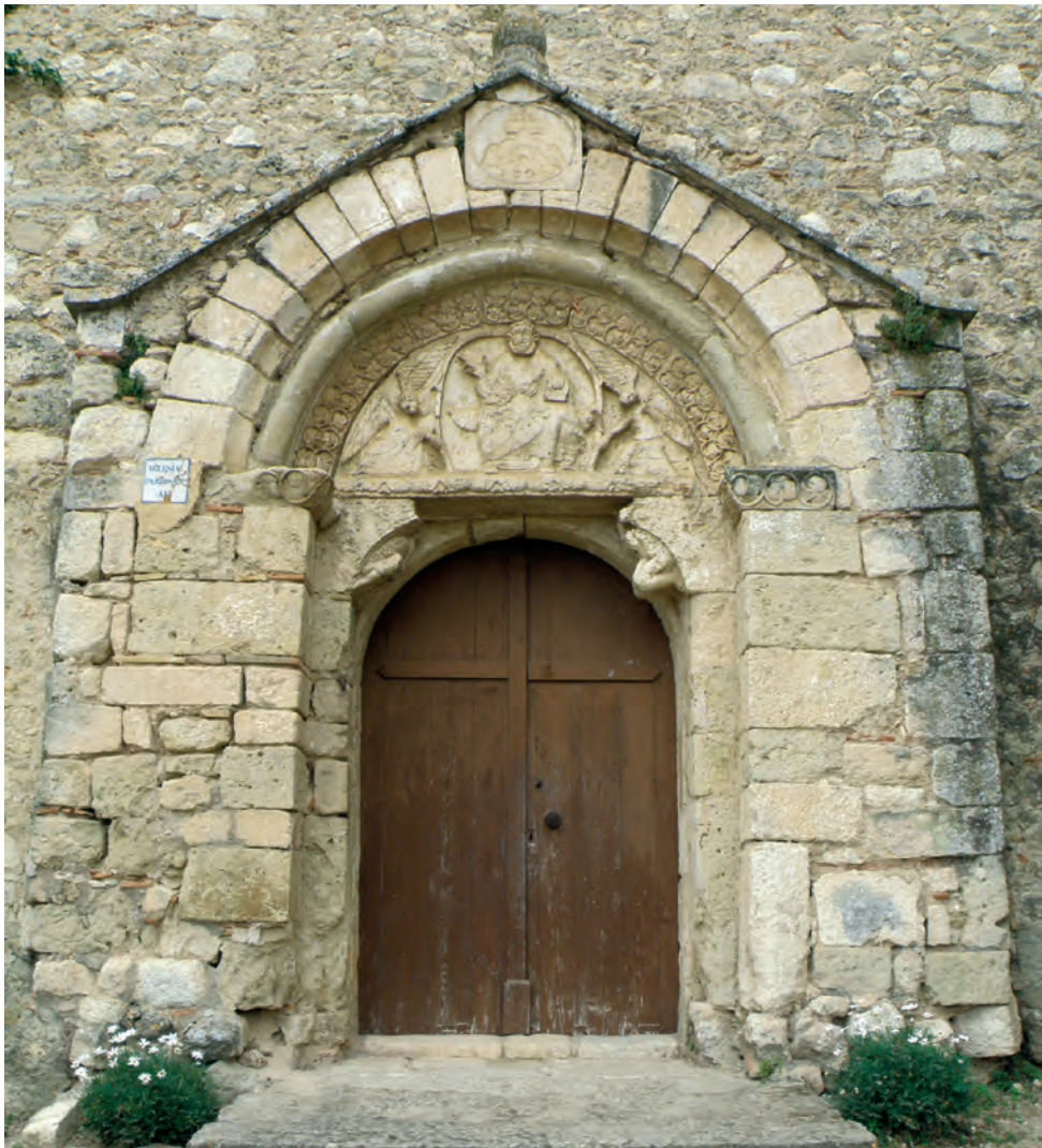
Portada en la fachada sur
