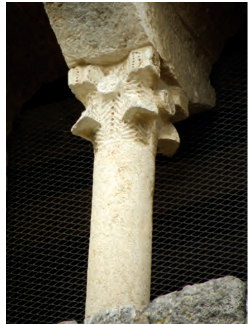
Capitel de una de las ventanas del campanario
