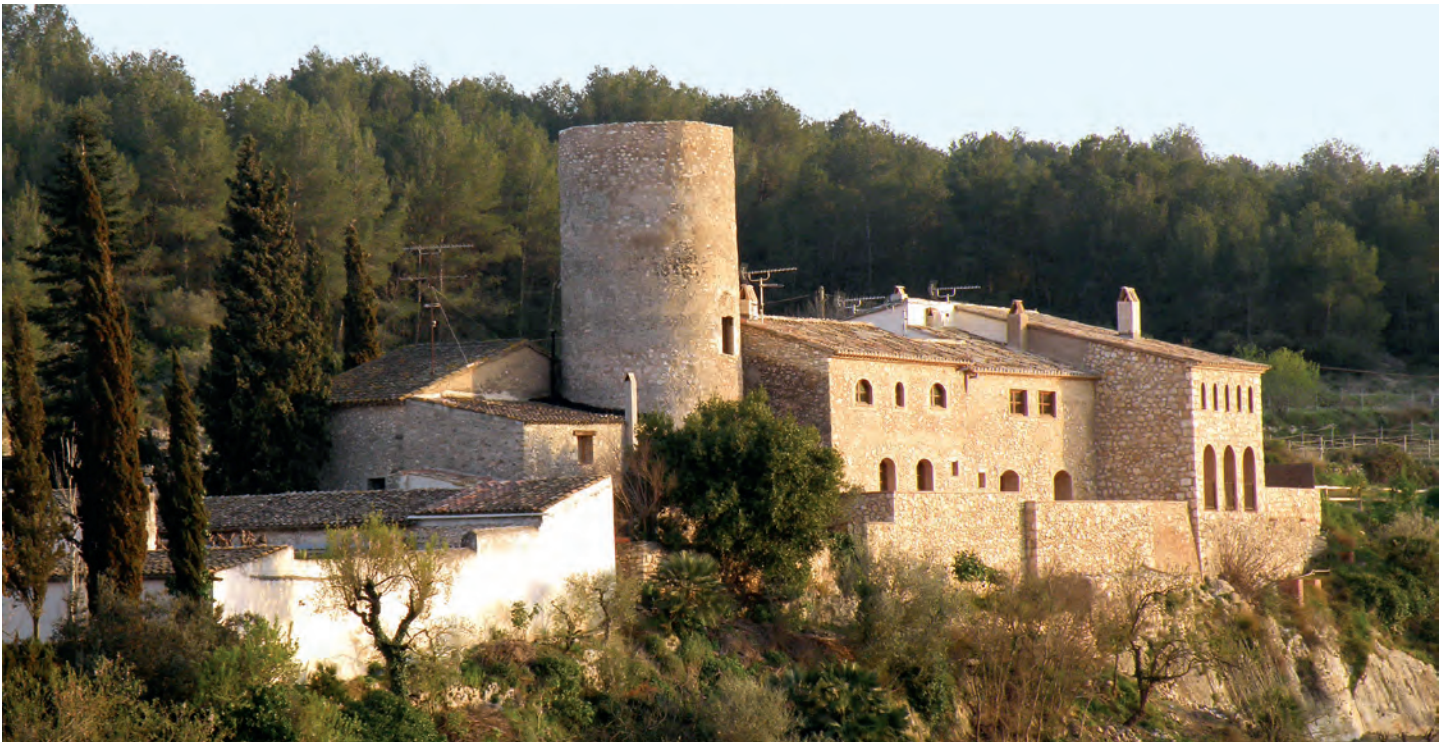
Vista general de la torre junto a la masía
