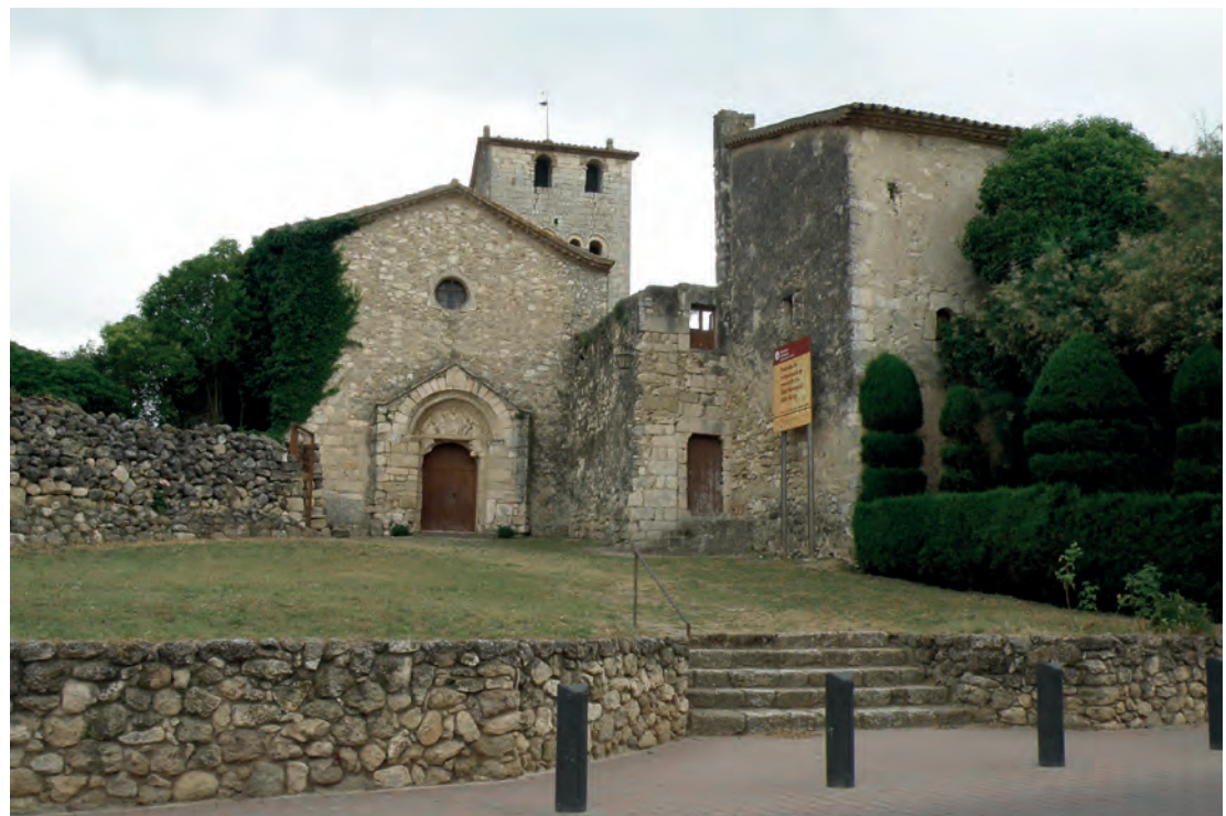
Vista general del conjunto
