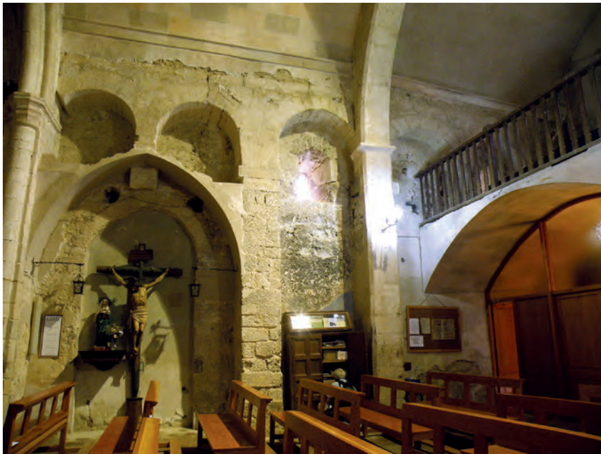
Restos de arcos formeros en el muro meridional
