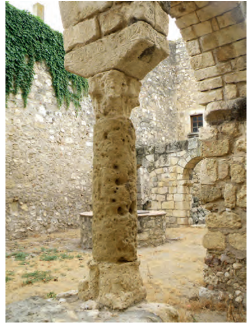
Columna oriental de la galería norte del claustro
