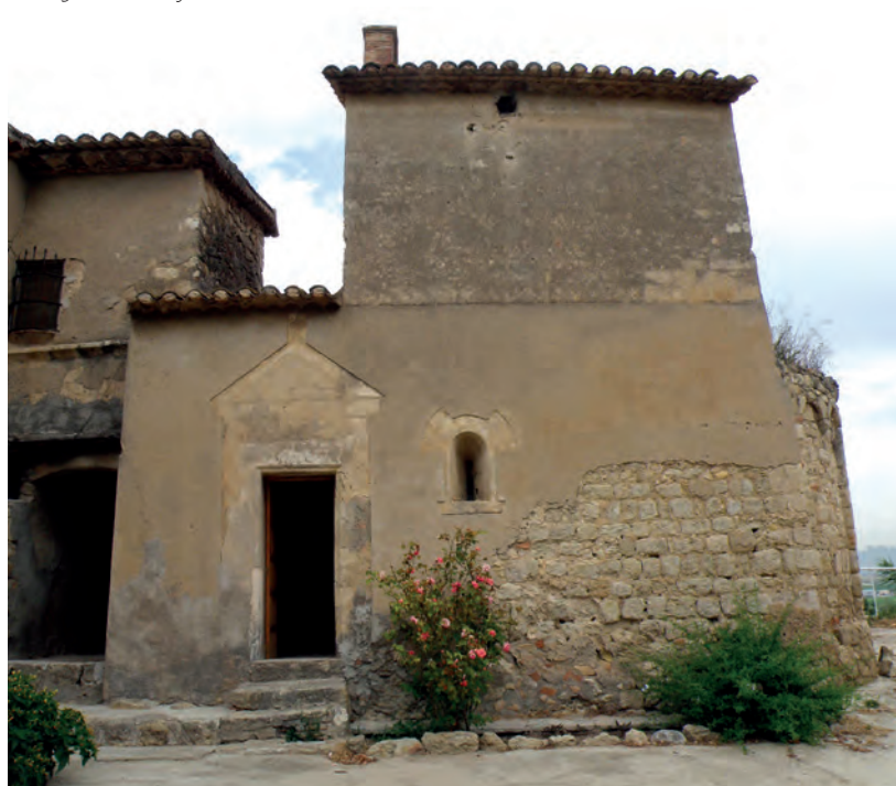
Vista general de la fachada meridional
