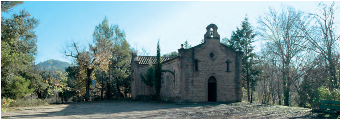
Vista general desde el noroeste
