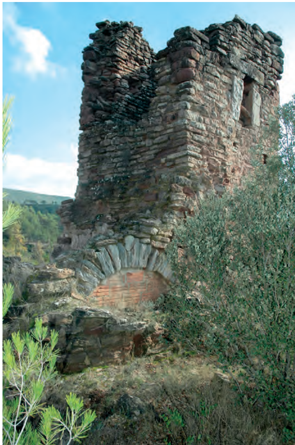
Arco triunfal del edificio prerrománico y torre románica
