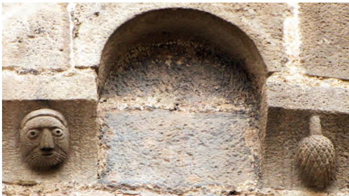
Detalle de las ménsulas
