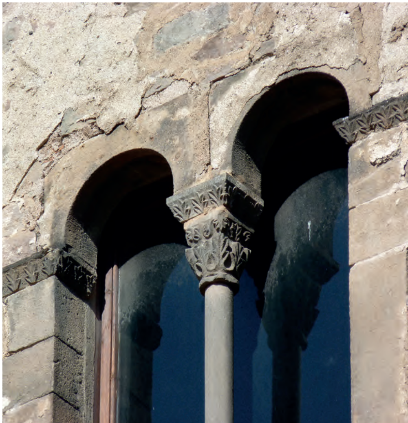
Ventana incorporada a la muralla
