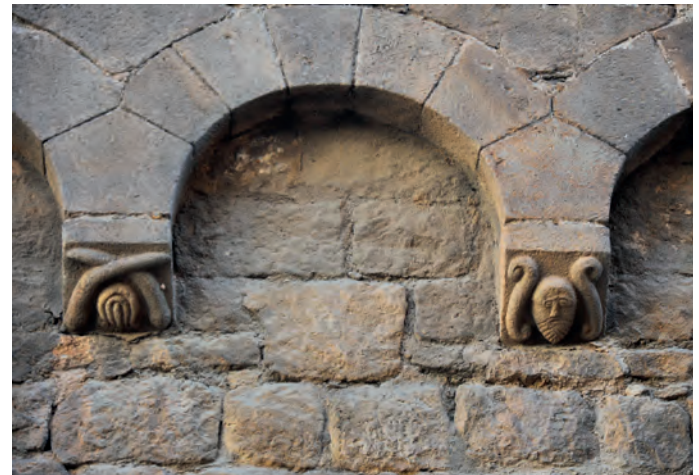
Detalle de las arcuaciones ciegas de la fachada occidental
