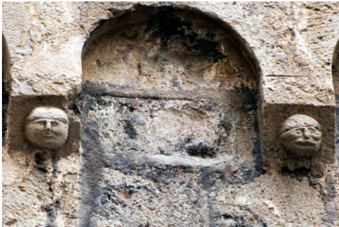
Detalle de las ménsulas
