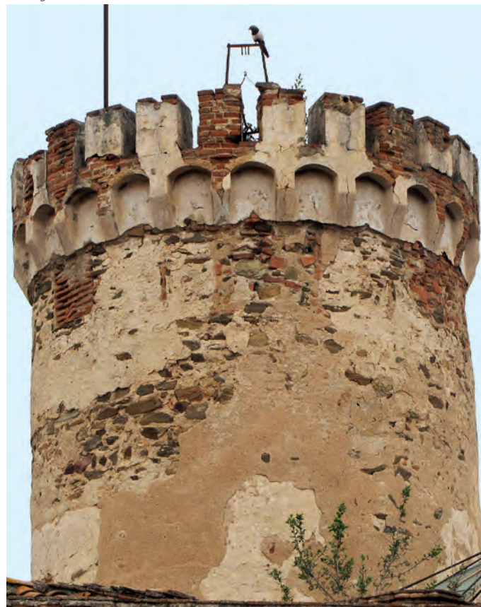
Vista general de la torre
