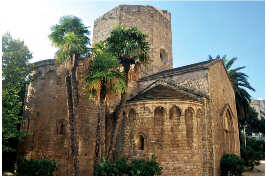
Vista general de la cabecera
