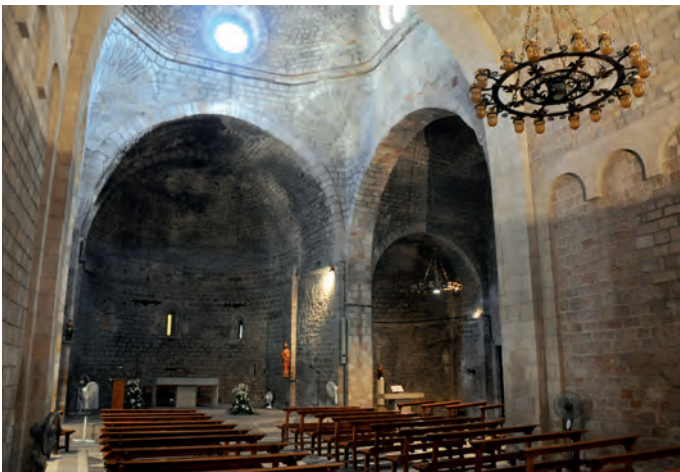
Interior de la nave central
