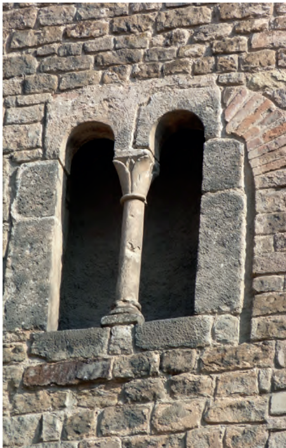
Ventana incorporada a la muralla
