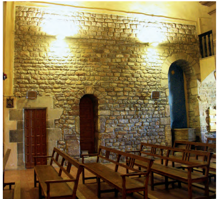
Interior del muro sur
