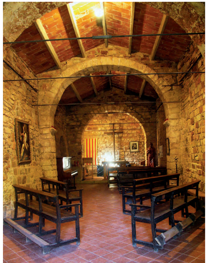
Estado actual del interior del edificio
