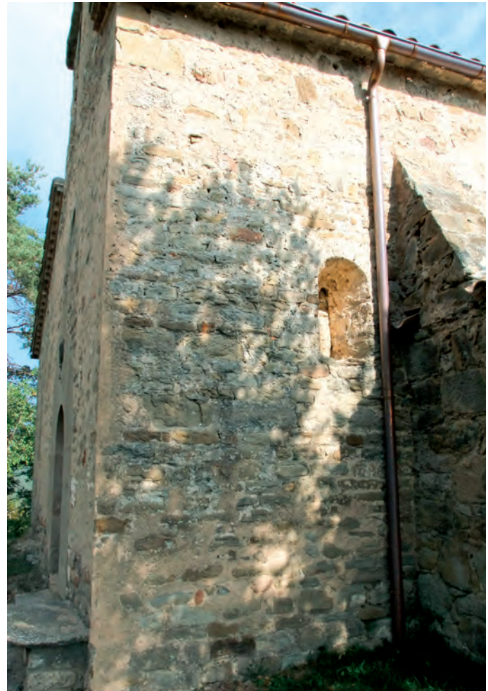
Detalle del muro sur con la ventana cegada
