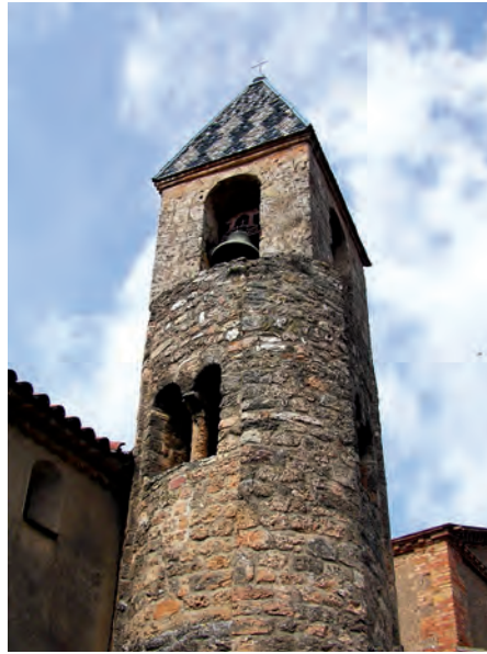
Detalle de la torre
