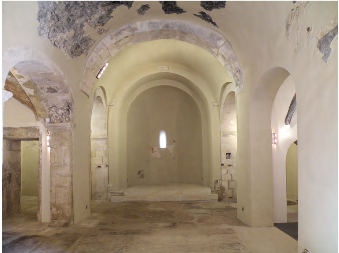
Interior hacia la cabecera
