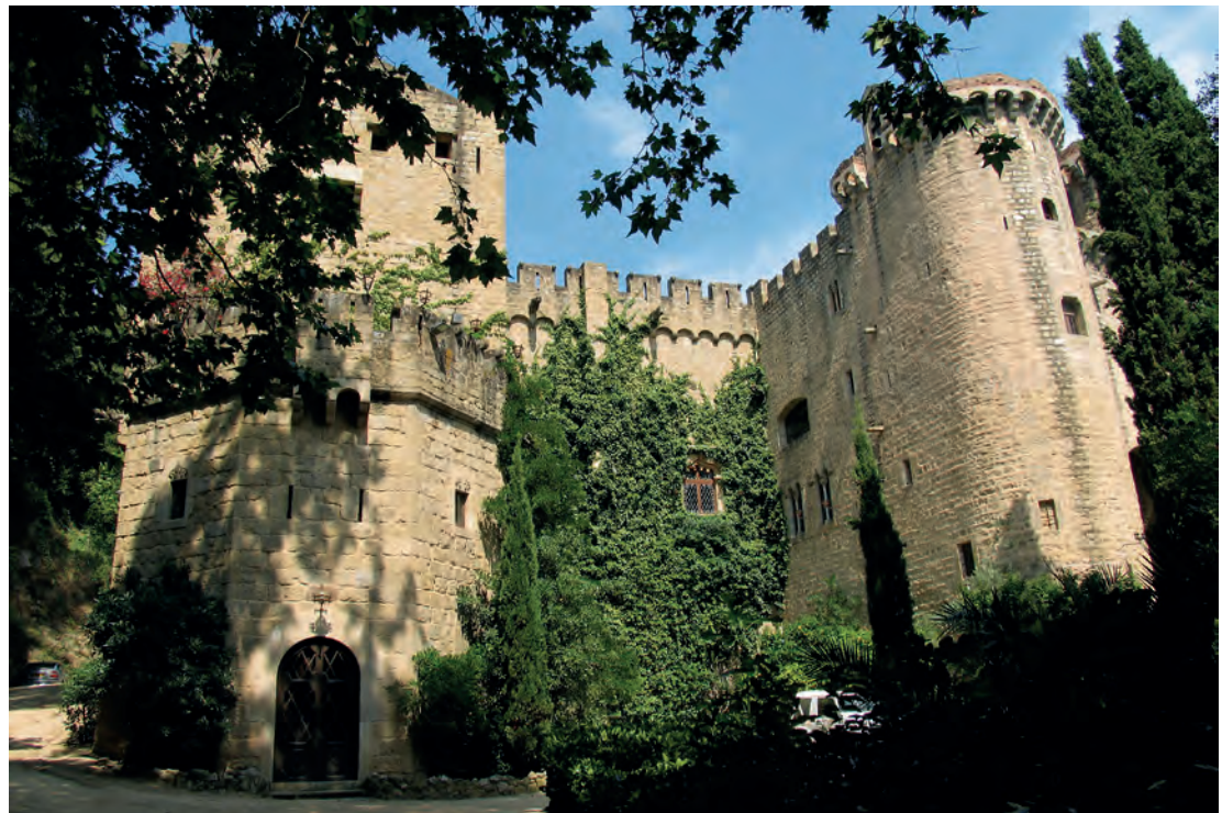
Estado actual del edificio
