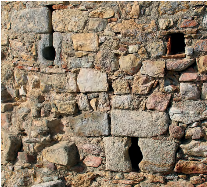
Aspilleras de la zona inferior de la torre
