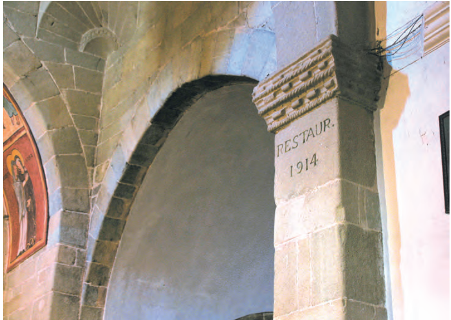
Detalle de la imposta del arco toral y de la trompa del cimborrio
