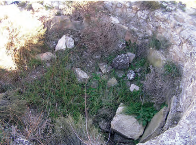
Restos de la cisterna
