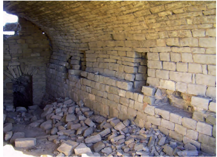
Detalle de la sala abovedada
