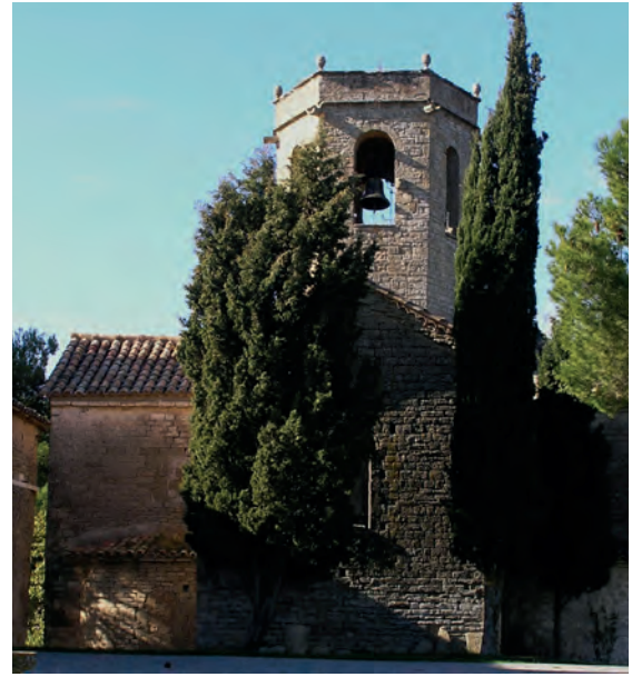
Vista desde el lado este
