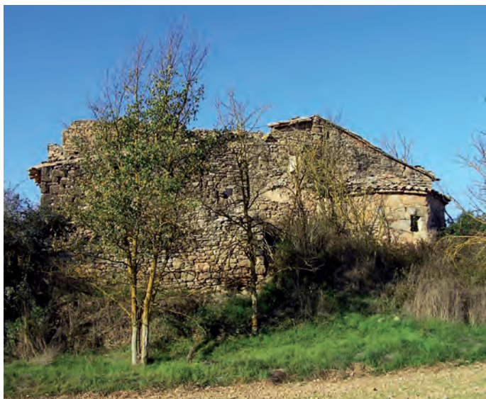
Vista desde el lado este
