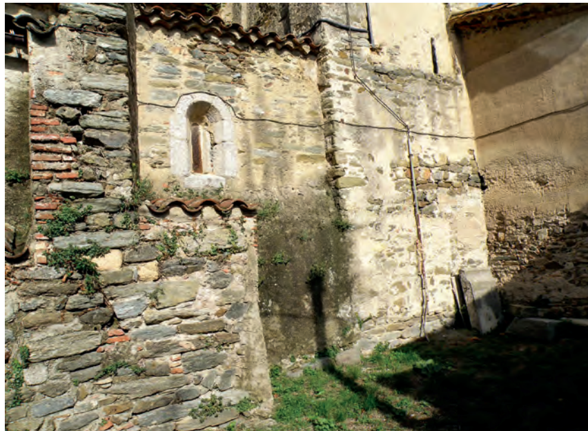
Antigua fachada occidental
