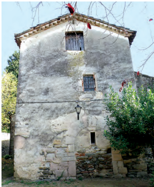
Antigua fachada occidental
