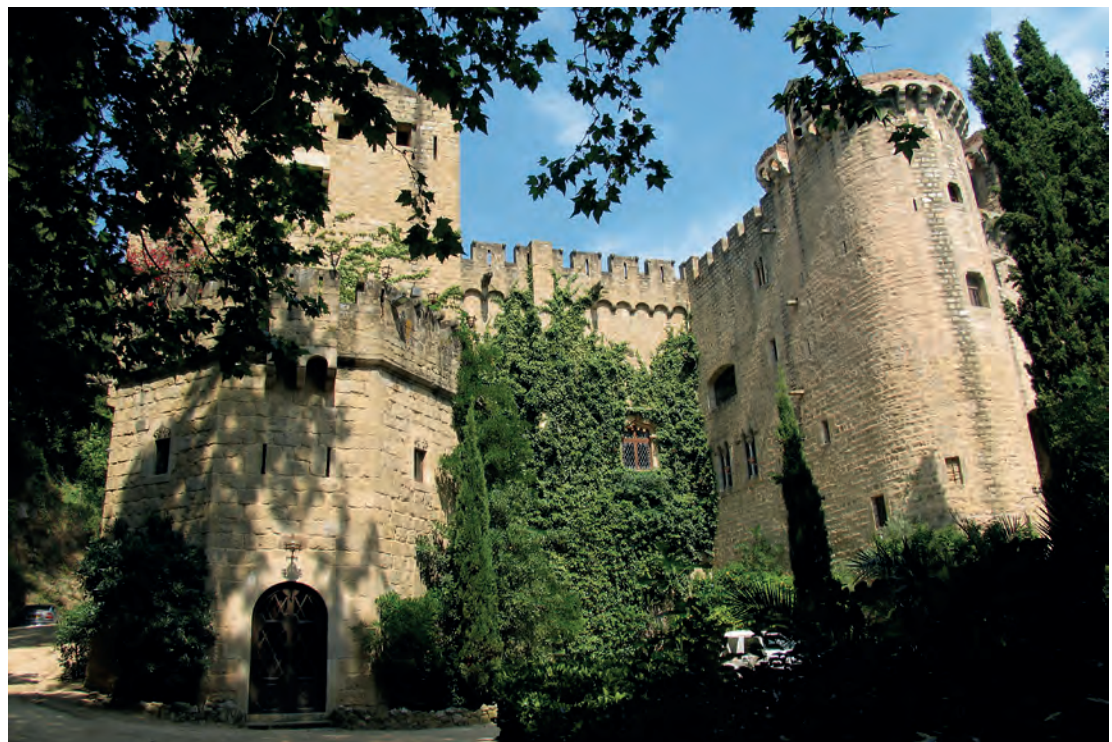
Estado actual del edificio
