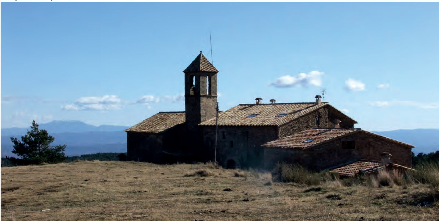
Vista general del conjunto
