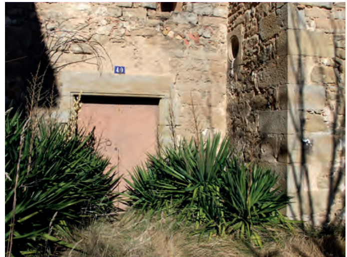
Restos de la posible portada en la fachada sur
