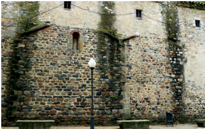
Restos románicos en el muro de la fachada norte
