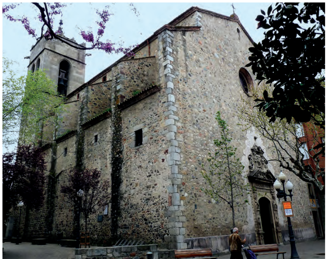
Estado actual del edificio
