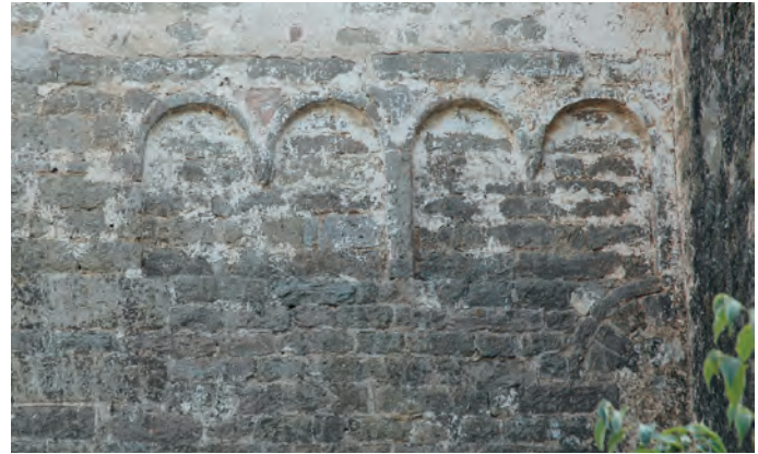
Arquillos ciegos en el muro norte de la antigua cabecera
