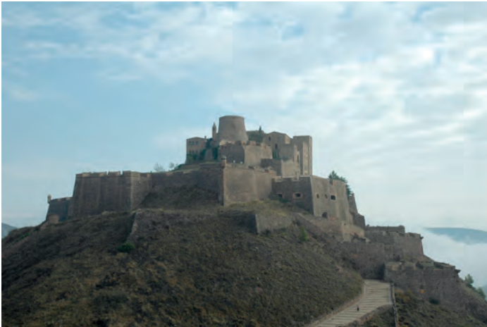
Vista general desde el Oeste
