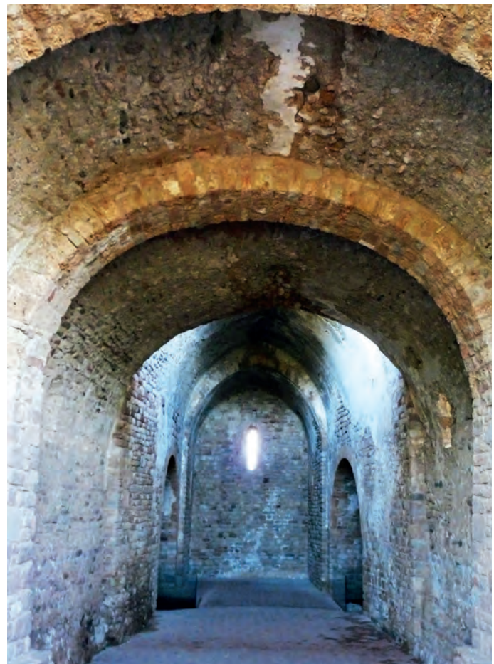
Interior de la nave
