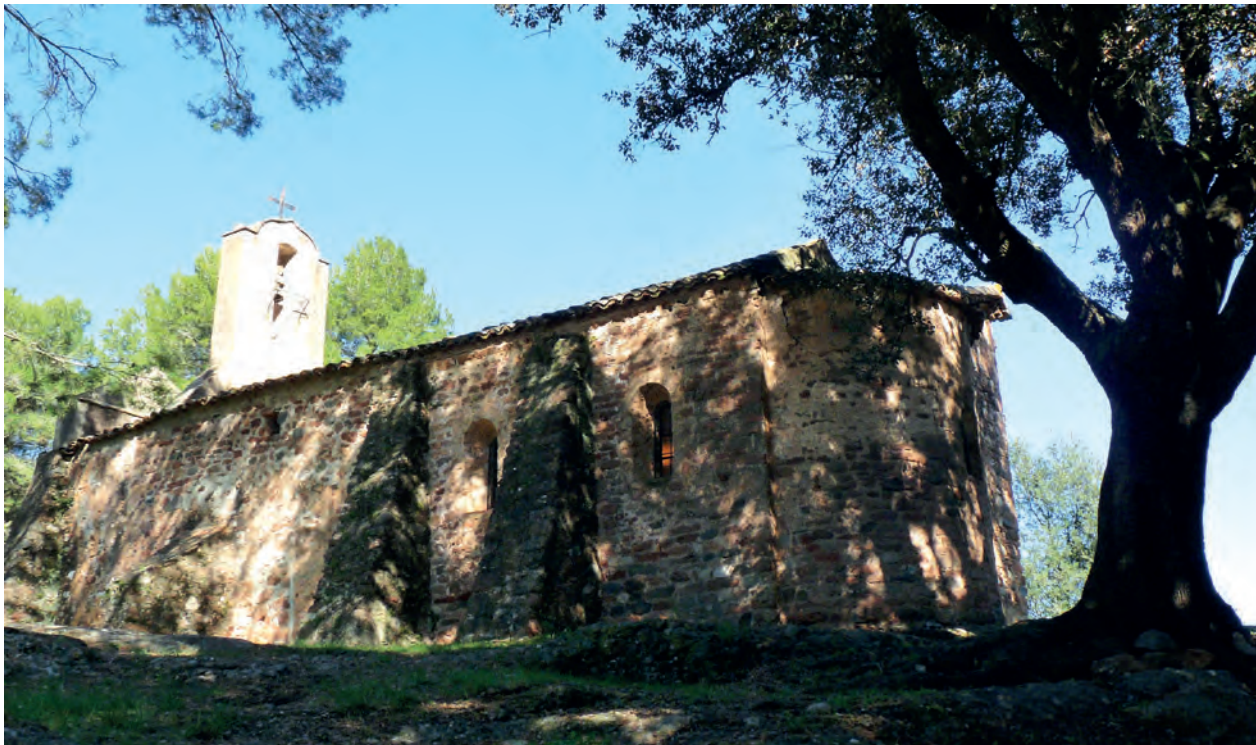
Fachada sur y cabecera
