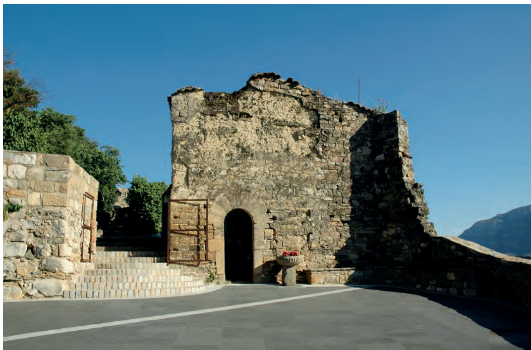
Vista de la capilla desde la fachada occidental
