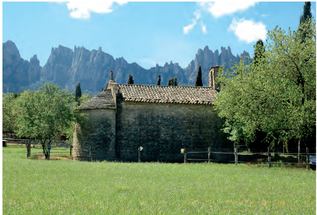
Vista general desde el Norte
