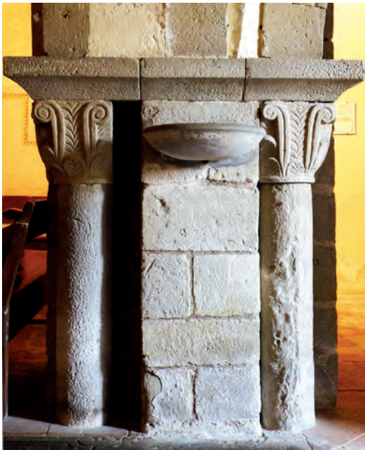
Estructura elevada occidental
