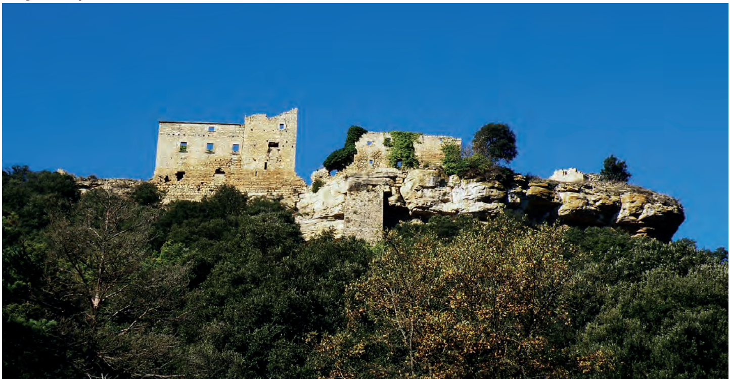
Vista general de la fortaleza
