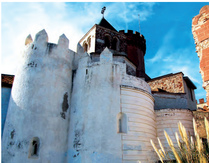
Vista general de la cabecera y el campanario
