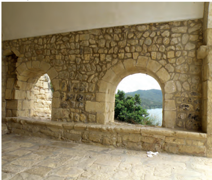
Detalle del pórtico
