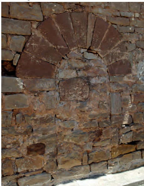
Portada cegada en el muro sur
